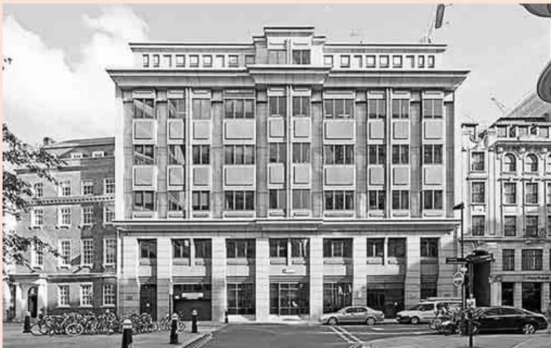
El edificio situado en el número 55 de la calle Moorgate, en la City de Londres, tiene 6.100 metros cuadrados y está alquilado a BNP Paribas hasta 2016 por una renta anual de 2,8 millones de libras (3,6 millones de euros).
