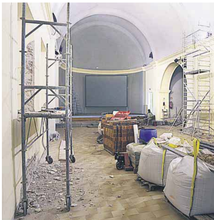
Imatge de les obres, ahir al matí, a la casa de cultura del Gironès ■ MANEL LLADÓ
