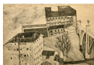
Esther Boix Bajo el viaducto 1955 Tinta xinesa sobre paper 30 x 44 cm Cortesia Galeria Marc Domènech
