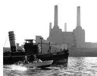
Embarcacions navegant pel Tàmesi. Al fons les quatre xemeneies, de maons, de la central termoelèctrica "Battersea Power Station" a Londres (1963) Còpia d'època, paper al gelatino-bromur de plata. 27x35 cm.
