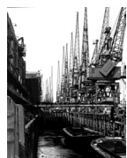
Grues instal·lades al moll de pilons construït sobre estacs del port de Londres (1963) Còpia d'època, paper al gelatino-bromur de plata. 27x35 cm.
